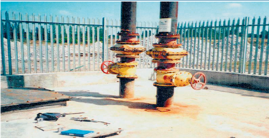
图 2.4 英国废弃矿井上的排气口
